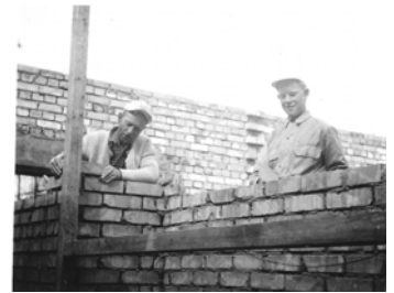
Ludwig Schiffel (links) und Erich Bielmeier auf der Schulhausbaustelle
