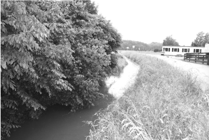
Der Graben an der Wacholderstraße im Bereich Kindergarten Thansau.
