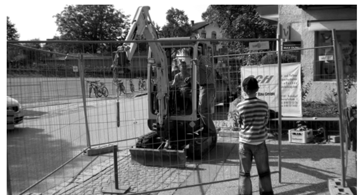
Übungen am Minibagger der Fa. Schauer Bau GmbH
