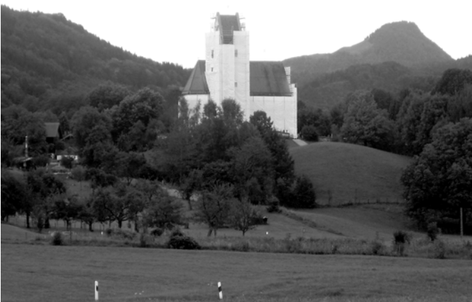
Die eingerüstete Kirche von Grainbach
