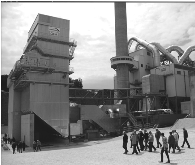
Besucherguppe unterwegs zur neuen SCR-Anlage
