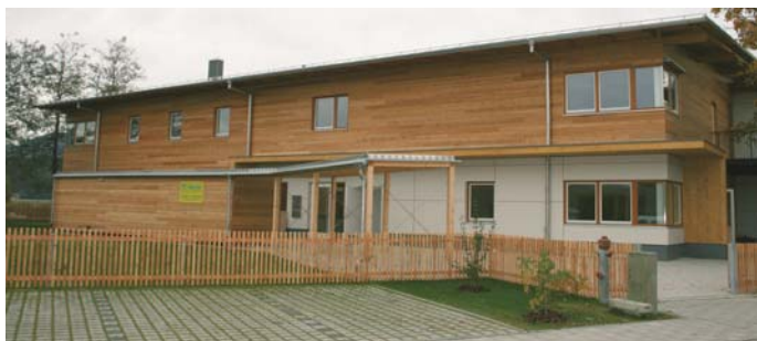
Vorderansicht des neuen Gebäudes
