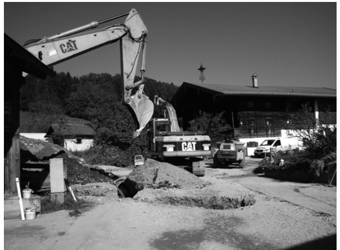
Der Kanalbau in Hundham ist mittlerweile abgeschlossen.
