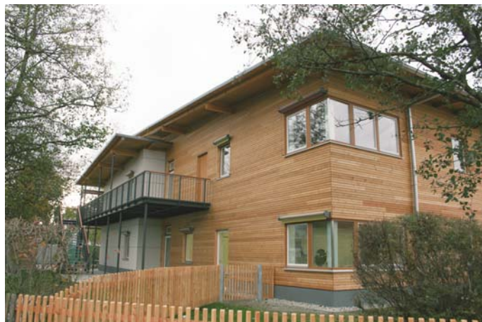
Zementfaserplatten (links) und Holzverschalung (rechts) ergänzen sich optimal und gliedern die Außenfassade
