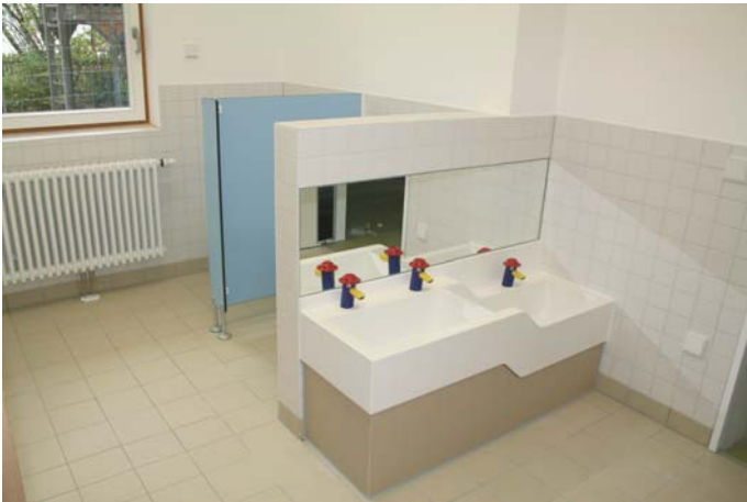
Blick in einen der kindgerechten Sanitärräume
