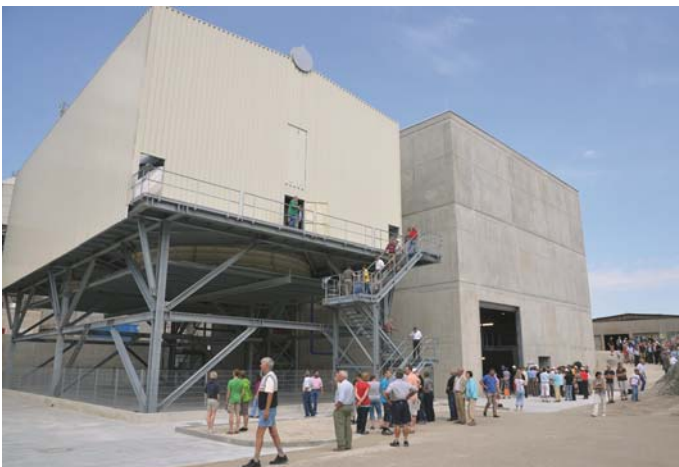
Das Abwärmekraftwerk ist europaweit die einzige Anlage in einem Zementwerk, die Abwärme in Strom umwandelt. Insgesamt wurden dafür ca. 31 Millionen Euro investiert. Am Tag der offenen Tür am 23. Juni nahmen rund 4.200 Besucher das Angebot wahr und ließen sich in zahlreichen Führungen das neue Abwärmekraftwerk sowie das gesamte Zementwerk zeigen
