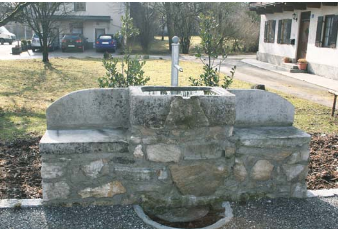
Der Dorfbrunnen nach der Erneuerung
