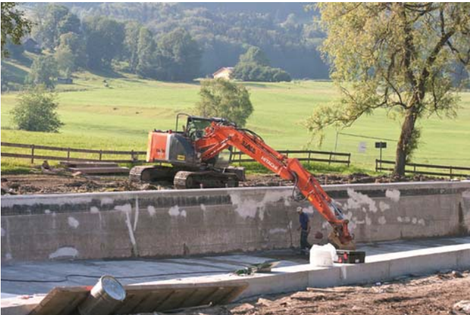
während der Bauphase
