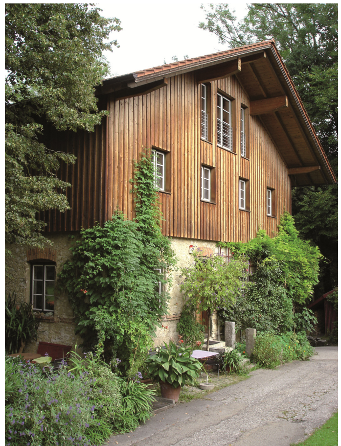
Südseite des Bräuhauses. Foto Silichner August 2019
