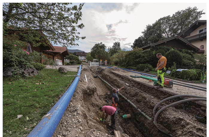
die Erdarbeiten im Ziehenweg
