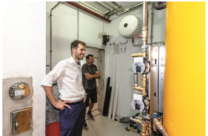
Bürgermeister Hausstetter besichtigt die Baustelle im Kindergarten; Konrad Hepfengraber (Heizungsbauer und Gemeinderat) erläutert Details
