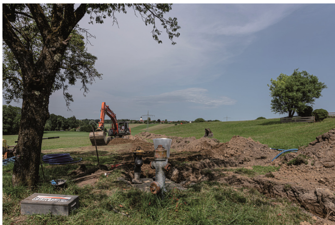
Wasserleitungsbau bei Sonnenleiten
